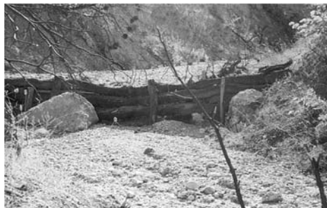
Φωτογραφία 6Α. Κανονική κατασκευή κορμοφράγματος.
