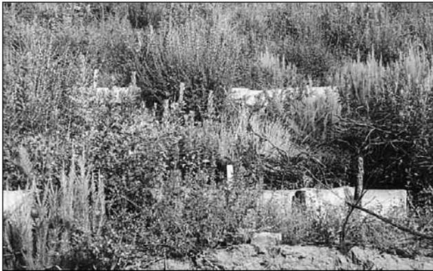
Φωτογραφία 4. Επανεγκατάσταση της βλάστησης και αναπλήρωση του σκοπού κατασκευής των κορμοδεμάτων (Μενίδι Ν. Άρτας).
