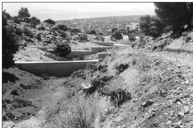
Φωτογραφία 7. Κατασκευή φραγμάτων από σκυρόδεμα στα όρια ορεινής και πεδινής λεκάνης για τη συγκράτηση φερτών υλών μετά από πυρκαγιά (Φράγματα ΕΥΔΑΠ στην Αττική).
