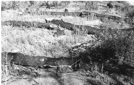
Φωτογραφία 3Α. Κανονική κατασκευή κορμοδεμάτων.
