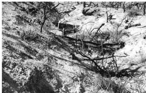
Φωτογραφία 6Β. Κατασκευή κορμοφράγματος που δεν ενδείκνυται.
